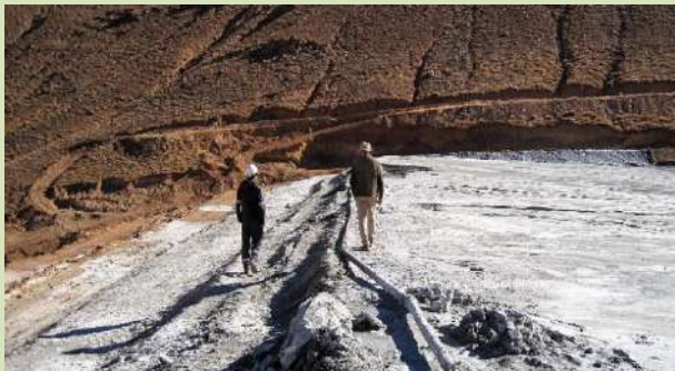
La crête du mur ne présente pas de signes de défaillance ou d'érosion. Il n'y a pas d'eau en son contact
