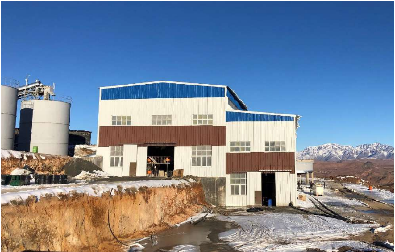
Figure 5 : Usine de flottation
